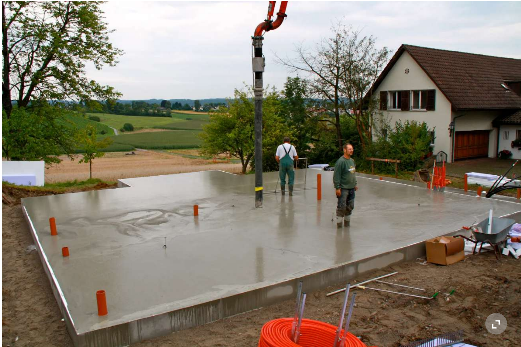
Auf diesem Fundament wurde das Haus erstellt.
